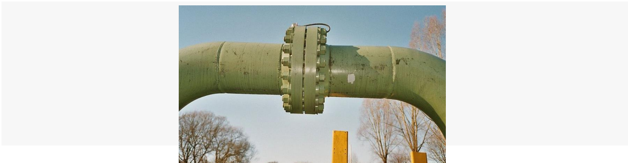
Figura 13 – Flange per tubazioni ad alte pressioni
