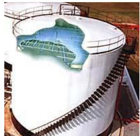
Figura 3 – Serbatoi a tetto flottante
