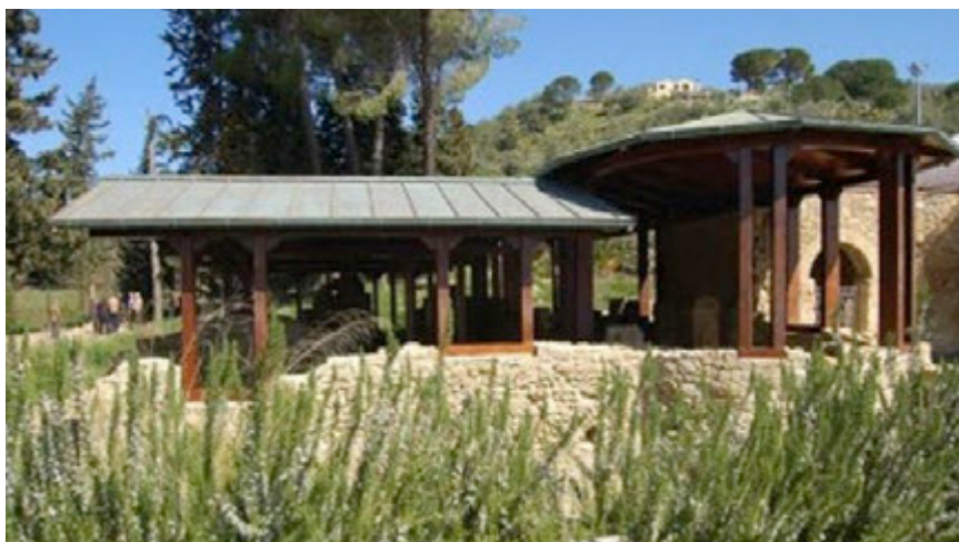
FIG. 12 - Nuova copertura: corpo termale della villa
