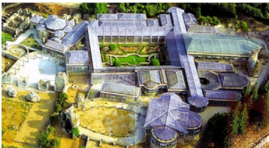
FIG. 3 - Vista della Villa con il sistema di copertura realizzato da F. Minissi dall'alto
