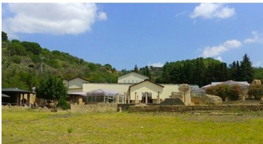
FIG. 10 - Intervento 2000. Nuova copertura realizzata da Guido Meli, esterno
