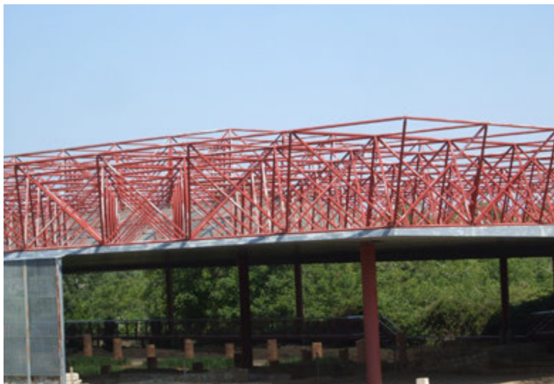
FIG. 5 - Particolare della copertura esterna (foto d. A.)
