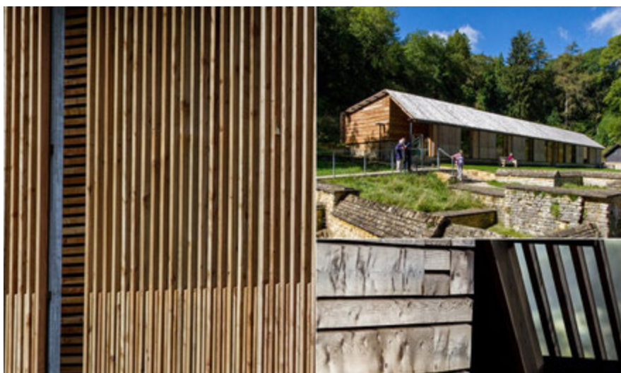
FIG. 5 - La struttura lamellare in larice della copertura moderna (foto Feilden Clegg Bradley Studios)
