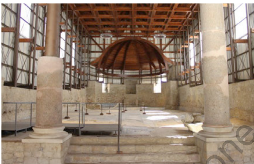
FIG. 14 - Allestimento della grande Aula basilicale absidata
