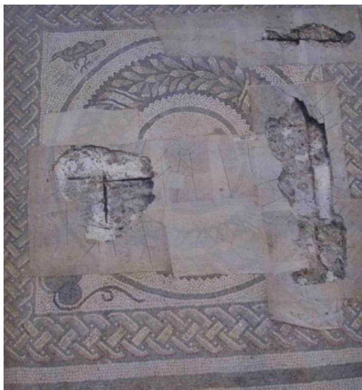
FIG. 7 - Stato di conservazione del mosaico degli ambulacri del peristilio con affioramento del pannello in cemento armato degli anni '60, particolare (foto d. A.)
